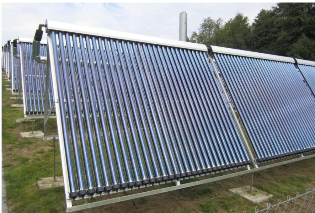
Joonis 7.4. Päikesepaneelid sooja vee tootmiseks
