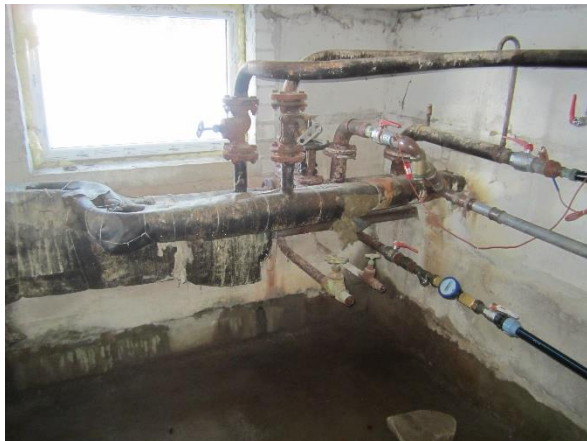
Joonis 3.6. Luha tn 12 hoone soojussõlm ning sotsiaalmaja ühendustorustiku liitumispunkt
