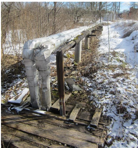
Joonis 3.5. Kolga-Jaani kaugküttevõrgu maapealne torustiku lõik
