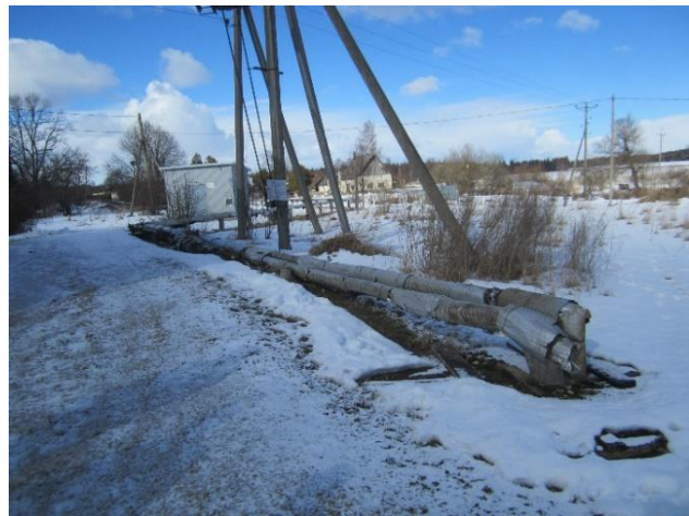
Joonis 3.5. Kolga-Jaani kaugküttevõrgu maapealne torustiku lõik
