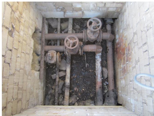
Joonis 3.6. Luha tn 12 hoone soojussõlm ning sotsiaalmaja ühendustorustiku liitumispunkt
