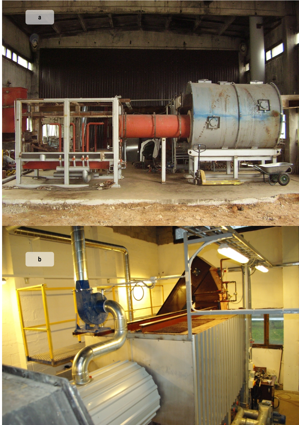
Joonis 3.1.1 – a). Mustla katlamaja ümberehitus, b). hakkepuidukatel
